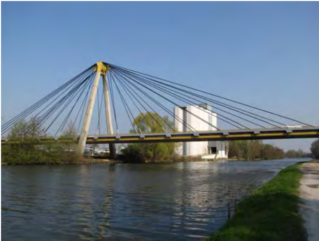
Pont haubané sur le Loing, Nemours Jean Muller / Marchal, 1997
