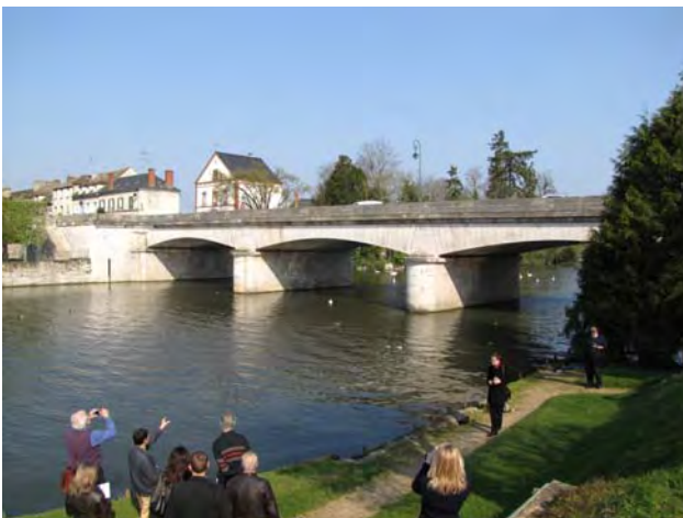
Pont sur le Loing, Nemours Jean-Rodolphe Perronet, 1804
