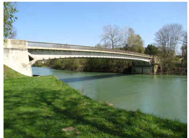
Pont sur la Marne, Luzancy Freyssinet, 1947
